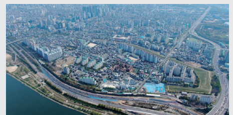
풍납토성 서성벽 일대 전경
